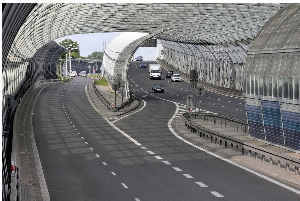
Rysunek 5. Nowoczesny ekran akustyczny na Trasie Toruńskiej w Warszawie
