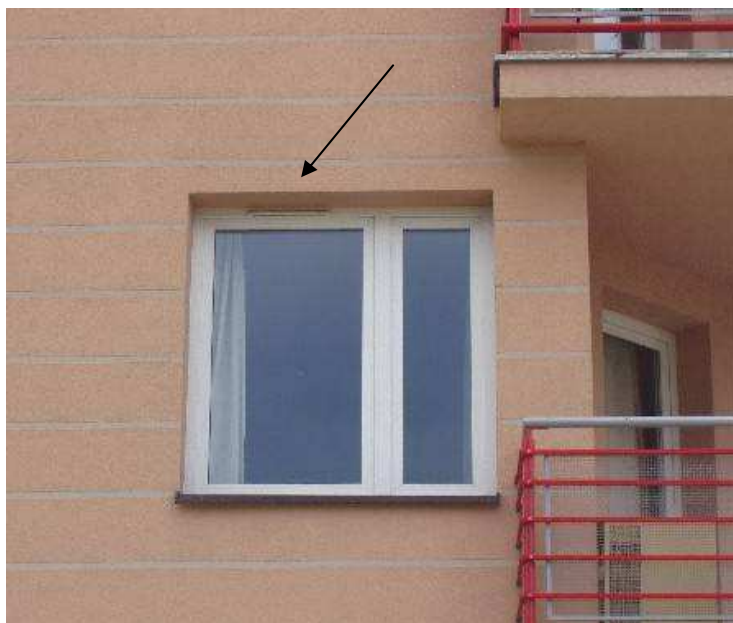
Rysunek 6. Okno dźwiękoszczelne z nawietrzakiem.
