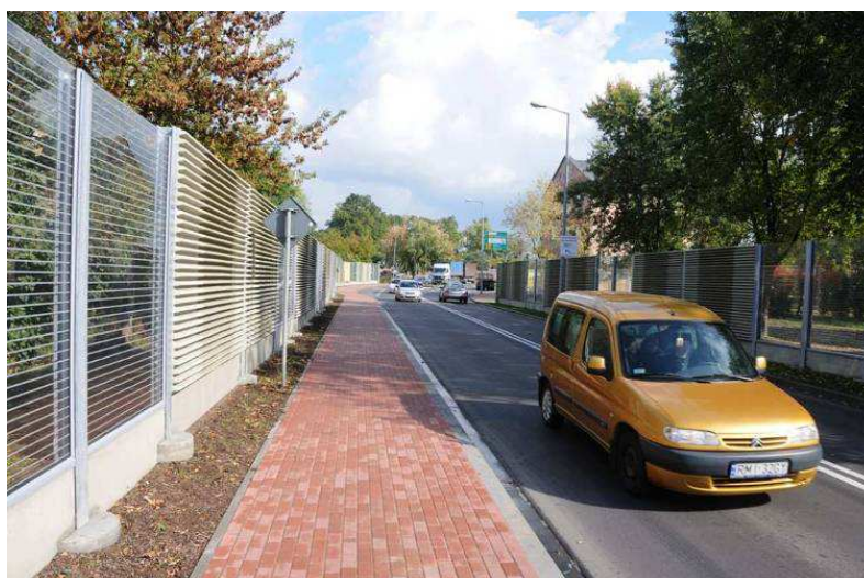
Rysunek 5. Ekran akustyczny z elementami przezroczystymi
