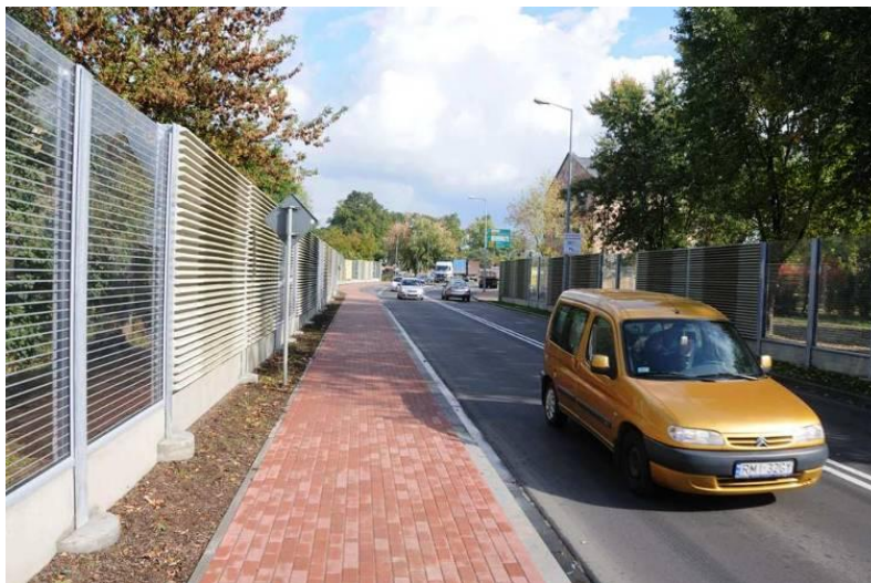
Rysunek 5. Ekran akustyczny z elementami przezroczystymi
